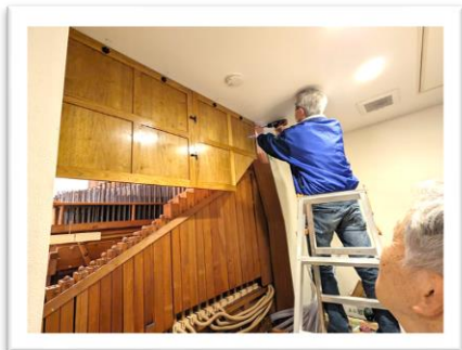
取付け作業中
